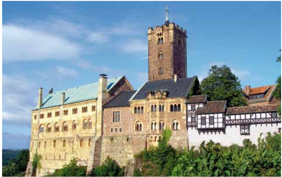
Die Wartburg in Eisenach. Hier hielt Friedrich der Weise von Sachsen den Reformator Martin Luther als "Junker Jörg" vom 4. Mai 1521 bis 1. März 1522 versteckt.
